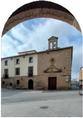
HOSPITAL de SOLSONA Fachada
